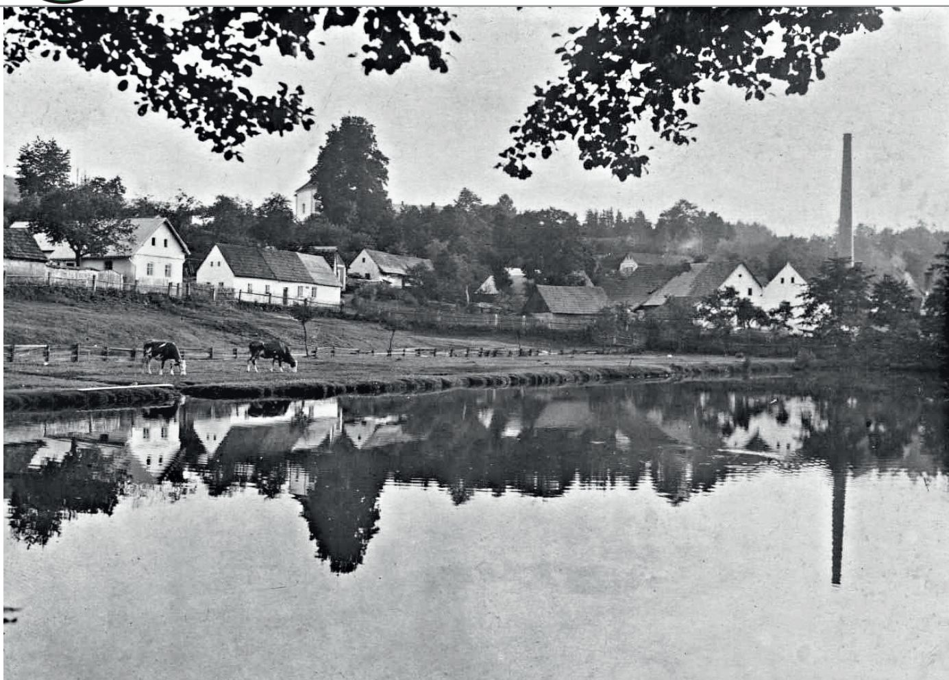
Historické fotografie: Skála – pohled přes Kotnův rybník
